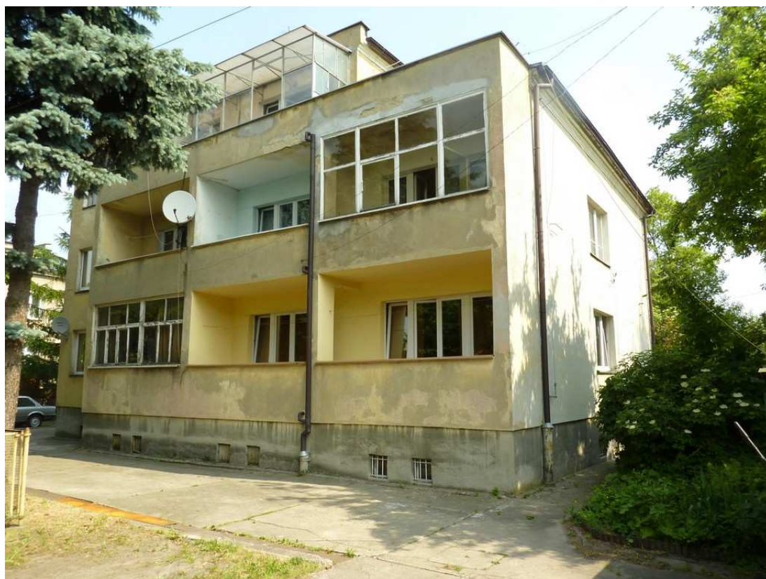
Fot. 2 Elewacja południowa
